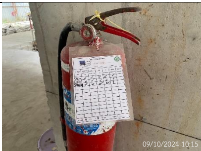
รูปที่ ผ7.52 การตรวจสอบถังดับเพลิงให้อยู่ในสภาพใช้งาน
