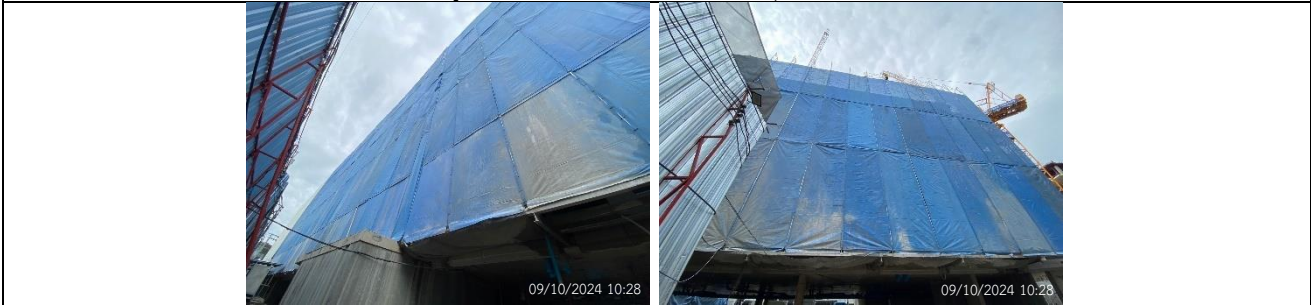
รูปที่ ๗7.12 ผ้าใบก่อสร้าง Mesh Sheet (แบบกันไฟลาม)
